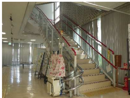
現公民館の屋内階段状況
