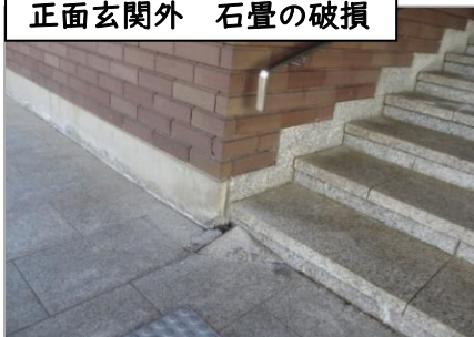
正面玄関外 石畳の破損
