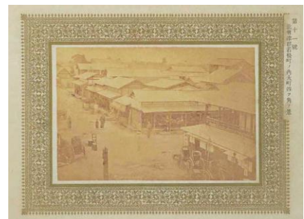
『福島県下諸景撮影』 第十一號 北會津郡若松町ノ内大町四ツ角ノ景
